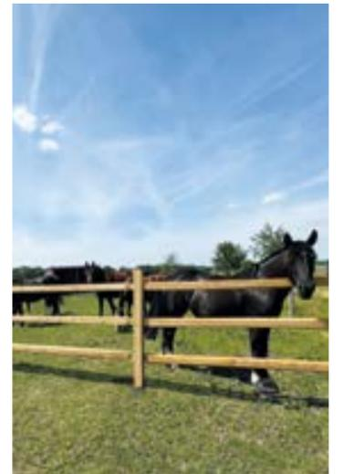
Das Robinio-Koppelzaun-System besteht aus Kantholz-Pfosten und drei Riegeln, die als Stecksystem verbaut werden.
